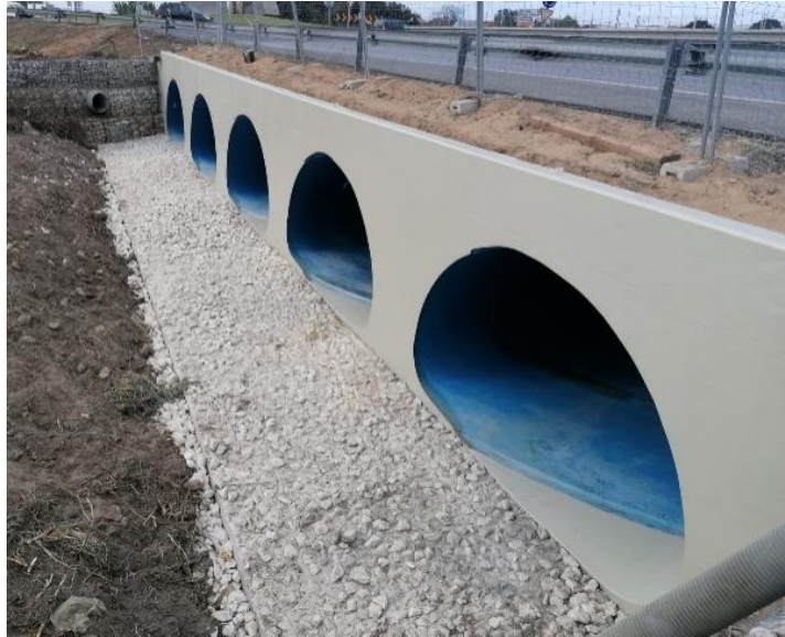
Figura 5.13 – Pormenor da pintura e do enrocamento.
