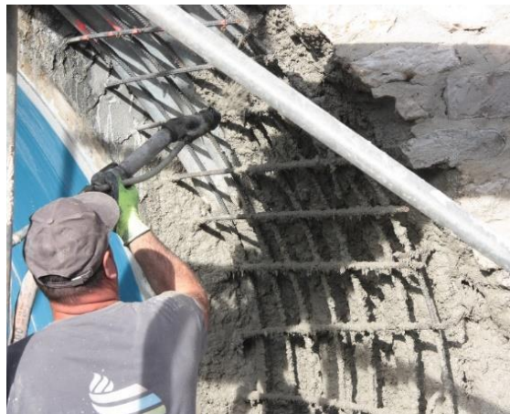
Figura 5.11 - Técnica de betão projectado.
