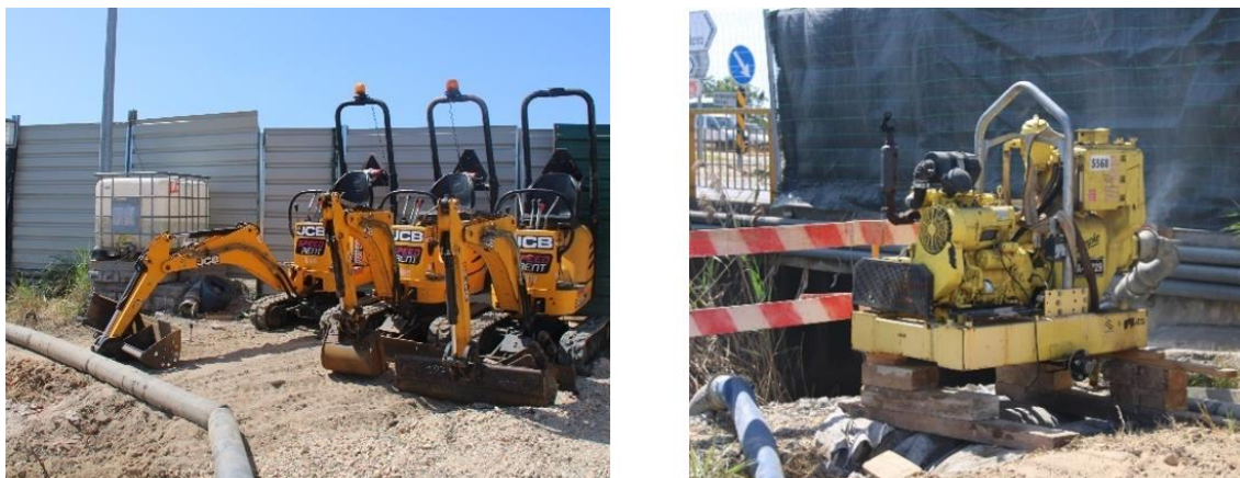
Figura 5.4 – Micro-escavadoras usadas na remoção de lodo (esquerda); bomba de sucção (direita).
