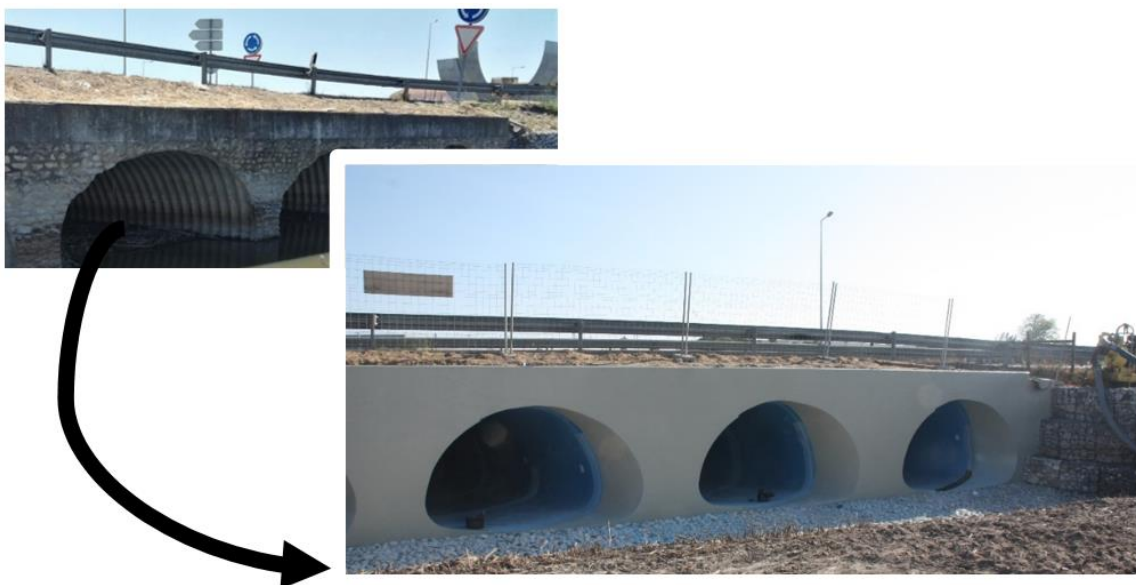
Figura 5.14 – Comparação do estado da PH antes e depois de reabilitada
