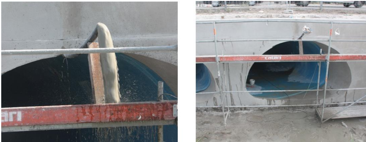
Figura 5.12 – Fim da injeção do grout numa passagem.
