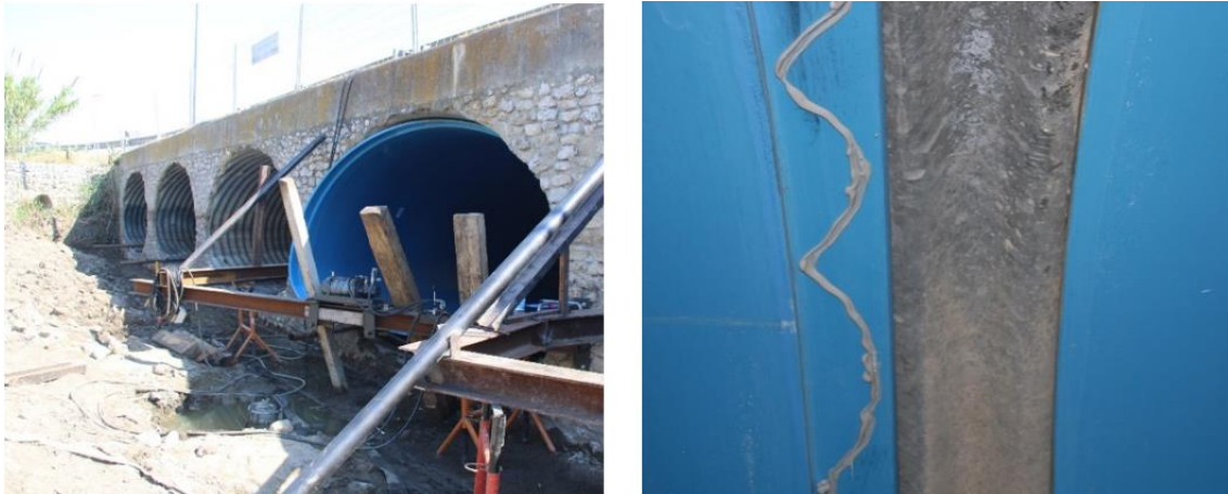
Figura 5.8 – Guincho mecânico (esquerda); ligação com reforço de silicone entre dois troços de tubo (direita)
