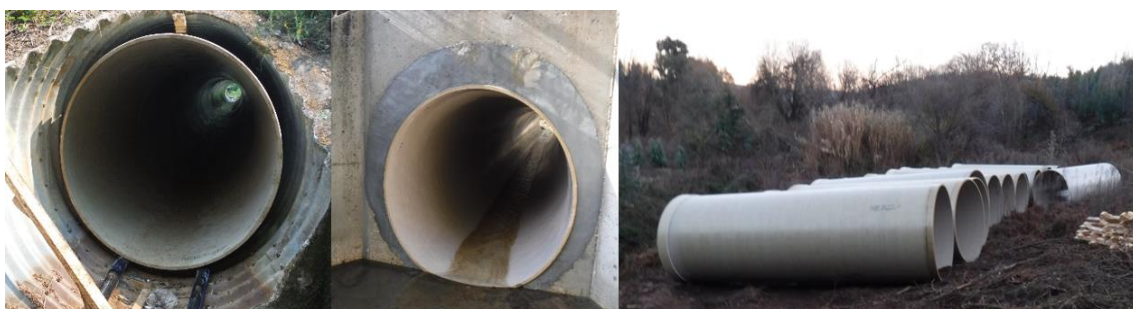
Figura 2.6 – Exemplo de reabilitação com entubamento em fibra de vidro.
