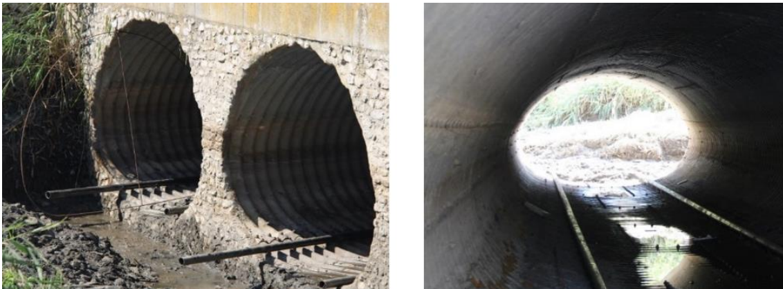
Figura 5.7 – Pormenor das calhas utilizadas como carris na colocação dos tubos de GFRP.
