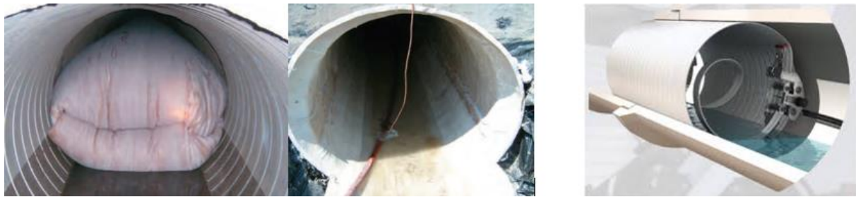
Figura 2.5 – Duas tecnologias inovadoras na reabilitação de tubagens: à esquerda, a Solução CIPP antes e depois de ser aplicada [17]; e, à direita, solução Ribline [18].
